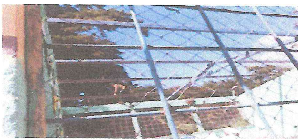
Foto 5: balcones de la escuela
